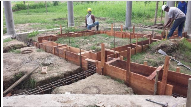
Foto 1: Viga de cimentación del mirador N° 2 - K0+280
