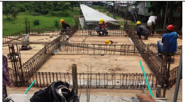
Foto 4: Amarre de hierro vigas aéreas del mirador N° 2 - K0+280
