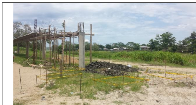
Foto 7: Localización, replanteo y excavaciones zapatas mirador N° 3 (Fin del sendero)
