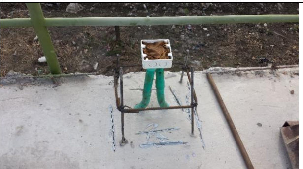
Foto 10: Refuerzo pedestales para postes de iluminación
