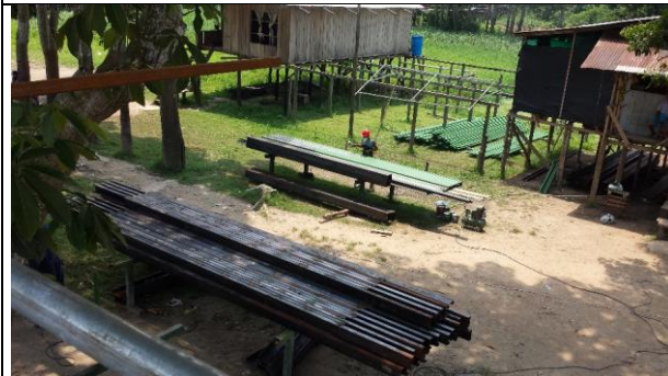
Foto 3: Perfiles C metálicos para los puentes colgantes
