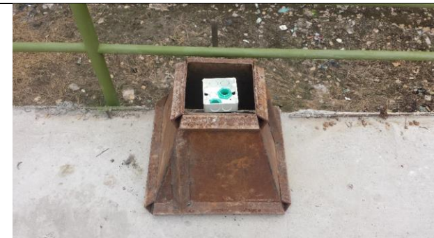
Foto 6: Formaleta para pedestales de postes de iluminación del sendero.
